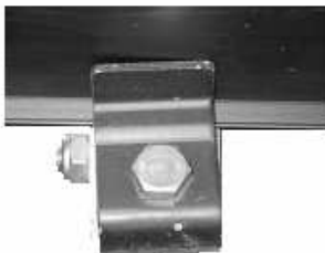
Afb. 36: Collector in Inhang-Z-profiel geplaatst.
