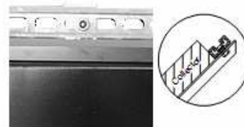
Afb. 37: Met montagerail, inbusschroef en moer de collector fixeren.
