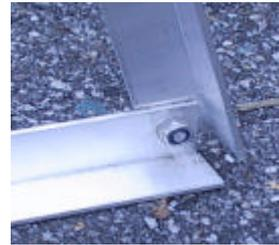
Bild 2: Eckverschraubung mit Sechskantschraube und Mutter
