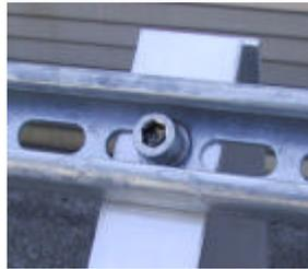
Bild 3: Montageschiene oben/ unten mit Inbusschraube und Mutter
