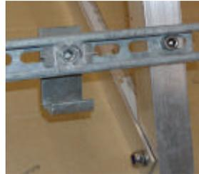
Bild 4: Eihängewinkel unten/oben montieren
